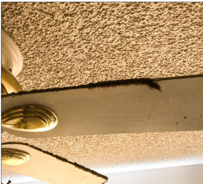
Dirty ceiling fan
